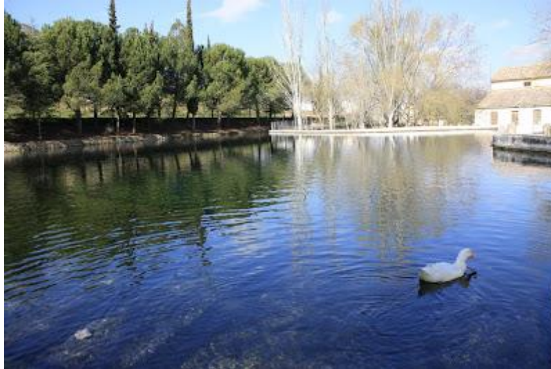
Nacimiento de Arbuniel y Central Hidroeléctrica San Manuel
