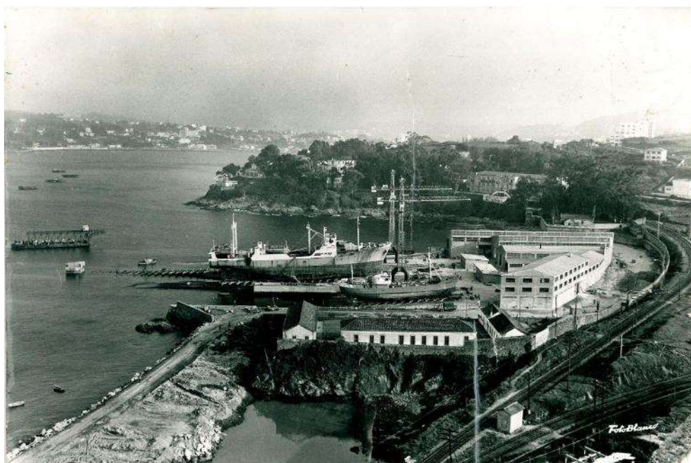
Figura 19: Rellenos de la playa de Oza para la construcción de varaderos sobre el solar del lazareto sucio. Al fondo, entre la vegetación, el antiguo lazareto limpio (izquierda) y el edificio de Colonias del Hospital de Oza (derecha). Circa 1970. Fuente: Archivo Foto Blanco. A Coruña.
