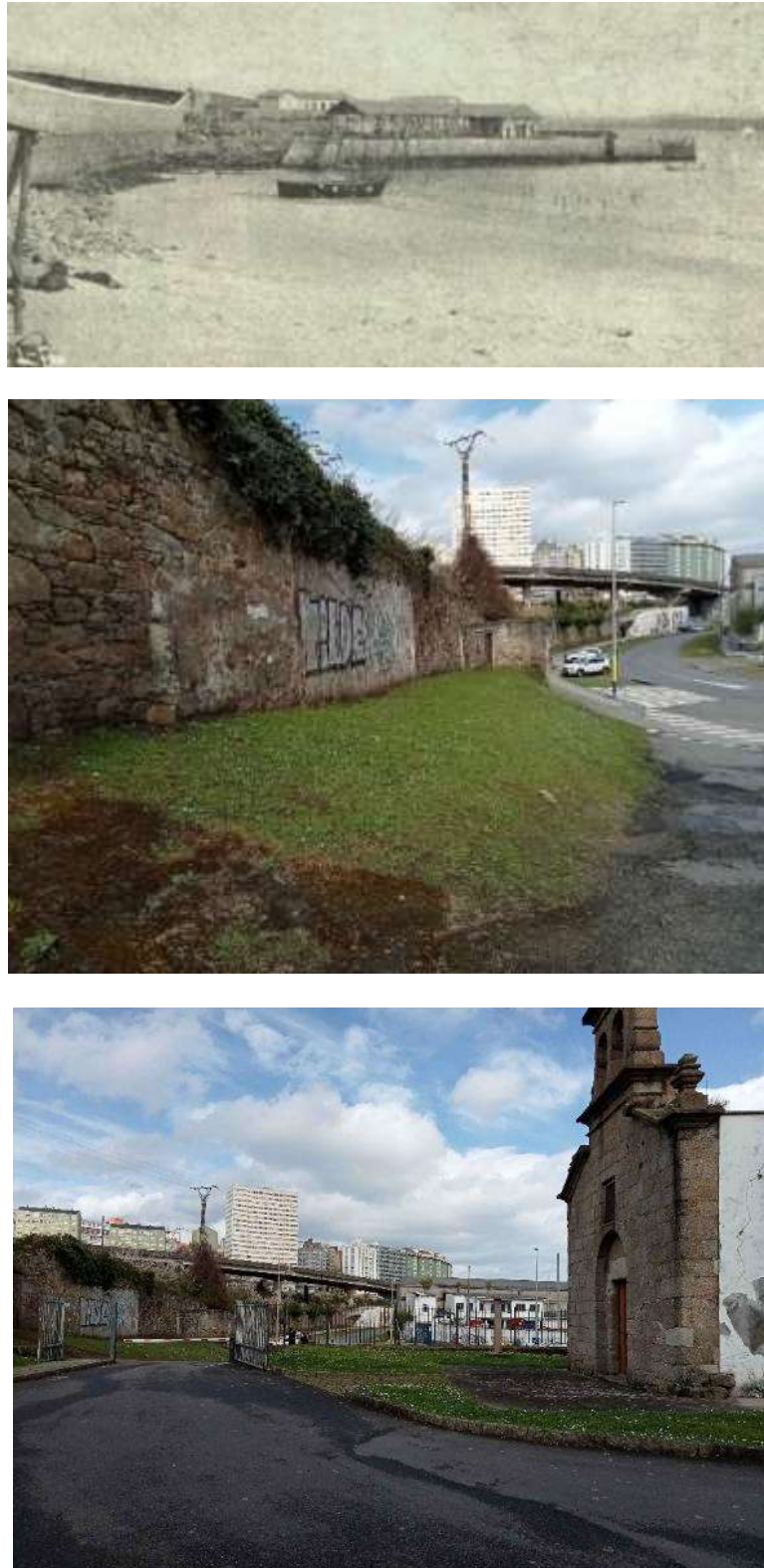
Figura 22: Vista de los restos del muro perimetral del lazareto, que persisten en la actualidad, a pesar de que la playa haya desaparecido en su totalidad. Fotografías del autor (marzo de 2025).
