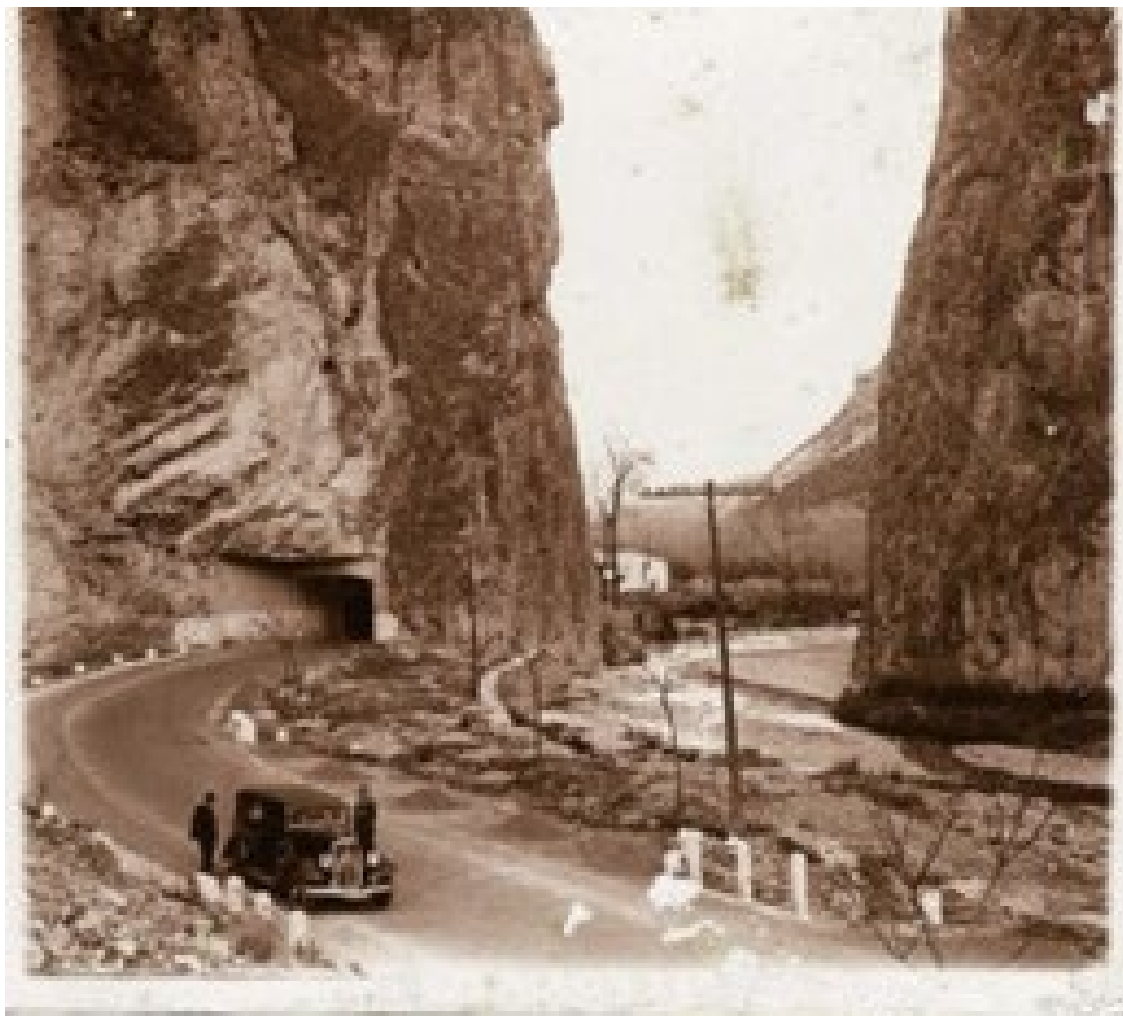
Túnel de Puerta de Arenas, década 1930. Fot. José Requena. Fondos Acacyr.
