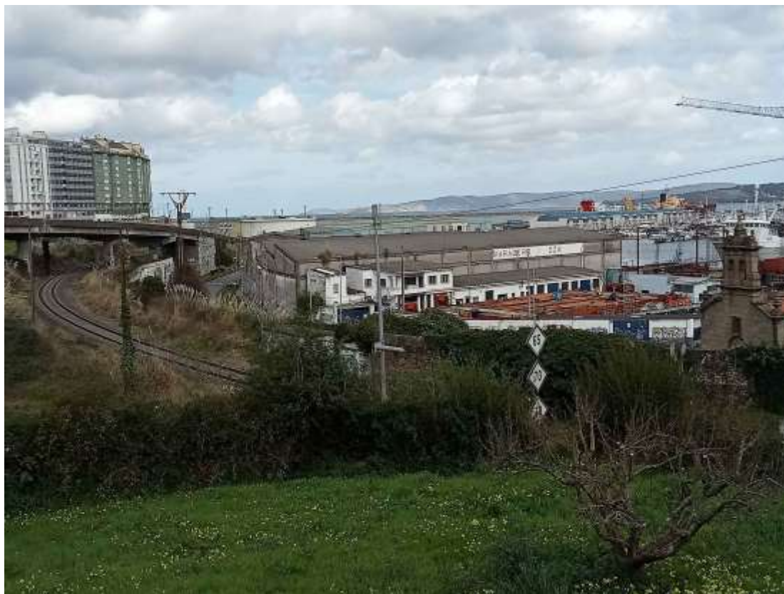
Figura 23: Perspectiva general del solar de la antigua playa de Oza. Las naves del varadero ocupan los terrenos del lazareto sucio. A la derecha, la espadaña de la capilla de Oza. Fotografía del autor (marzo de 2025).
