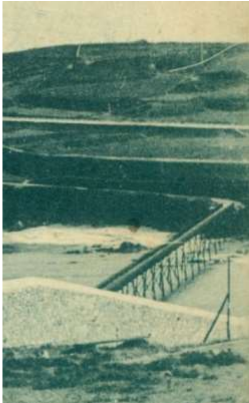
Figura 9: Ampliación de la fotografía anterior (figura 8); permite apreciar con mayor detalle la estructura de la pasarela de hierro sobre la playa de Oza.
