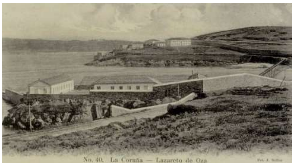
Figura 8: Vista general del Lazareto de Oza extramuros del lazareto sucio, en primer término (1901). Al fondo, el lazareto limpio y los primitivos pabellones del hospital. A la derecha, la pasarela que unía los dos lazaretos. Fuente: Fotografía de José Sellier. Archivo del Reino de Galicia. También accesible on line en GALICIANA.
