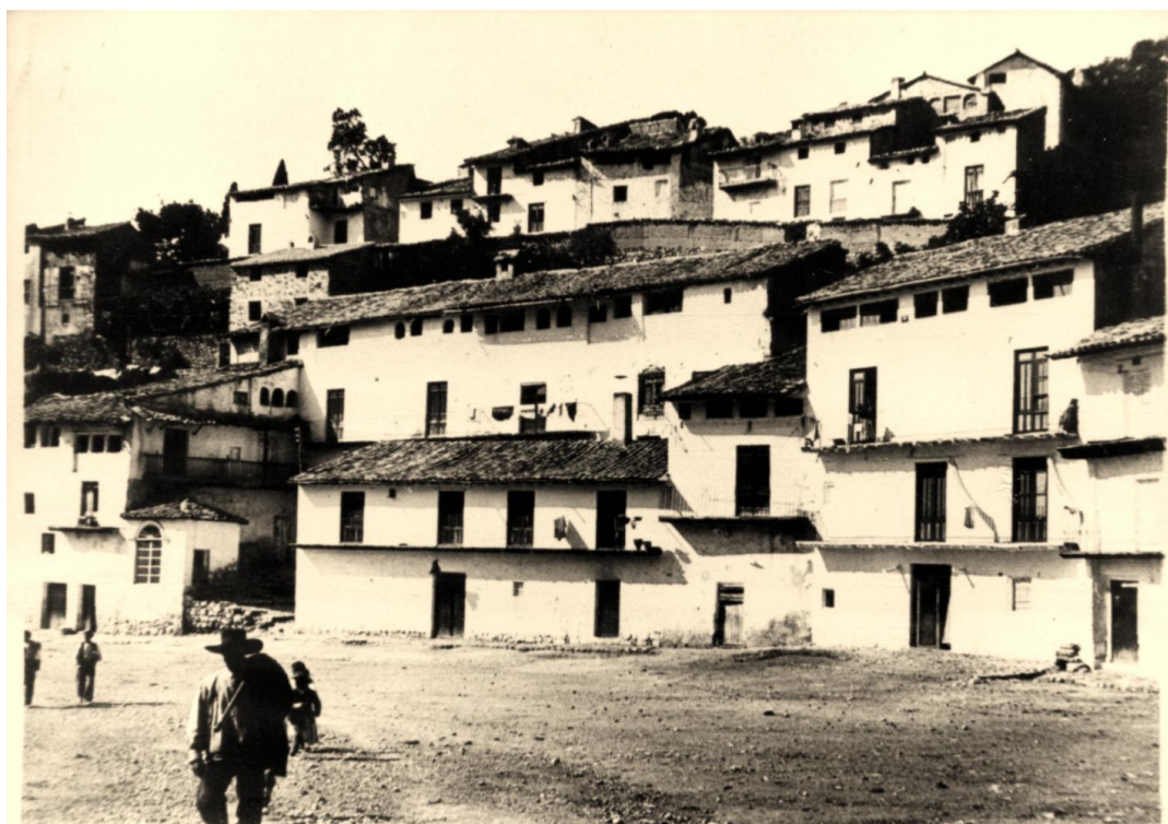
FOTO 5.- Plaza de Santa María: Casas del Corregidor. Cuando se toma esta fotografía el Ayuntamiento ya se había trasladado a La Merced, y se empiezan a construir unas casas delante de las Casas del Corregidor ocultándolas, ocupando el espacio, que a modo de gradas, daba acceso a las Casas del Corregidor (ver la Foto 8, donde se ve que como eran las gradas). A la izquierda la Capilla del Cristo de la Humildad, a cuyos pies se ajusticiaba a los reos. Más a la izquierda las « tiendas de escribanías ». Primeros años del siglo XX. Archivo particular del autor.
