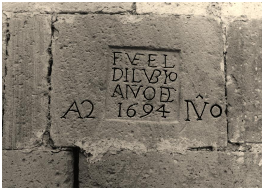
FOTO 7.- Piedra que recuerda el « Dilubyo » del día 2 de junio de 1694, cuando fueron arruinadas las Casas del Cabildo. Está colocada bajo la ventana de la torre del Baptisterio de Santa María. Fotografía de Pedro Gómez. Archivo particular del autor.
