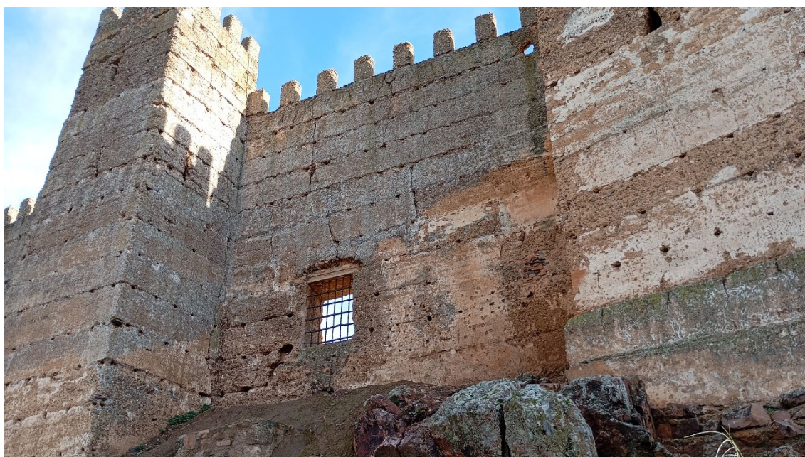
Lámina 13.- Paño noroeste del castillo de Baños. En detalle, pueden apreciarse las líneas de mechinales y los bloques del encofrado de la tabiya , características definitorias de la tapia de cal almohade.
