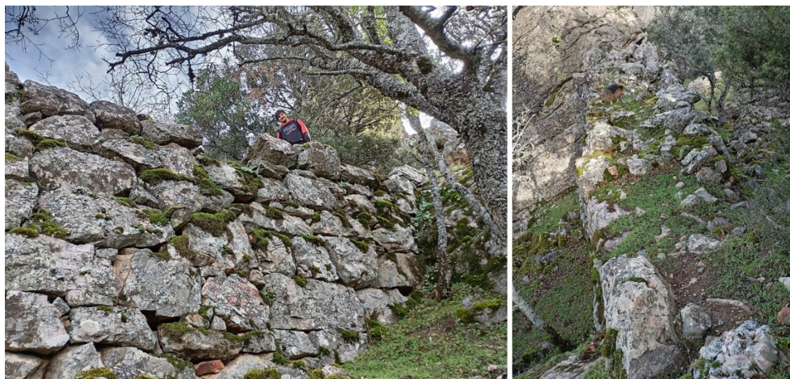
Lámina 10.- Muralla occidental y de carácter ciclópeo del castillo de Malaventura (CANTARERO et alter, 2026).
