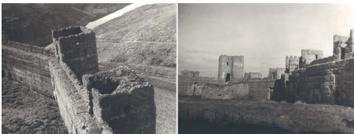
Lámina 1.- Estado ruinoso del castillo antes de su restauración: bóvedas, merlones, paños y torres 2 .
