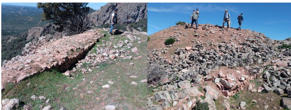
Lámina 7.- Muralla occidental de Burgalimar y derrumbe de la torre.
